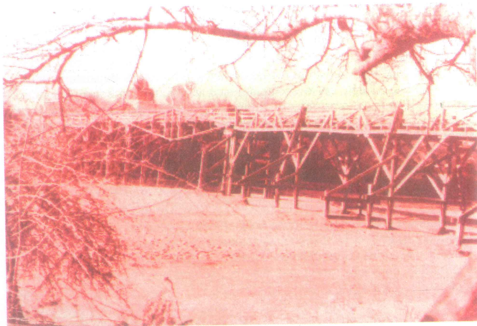
Foto 6. Puente de madera de quebracho, Villa Mercedes (San Luis).
