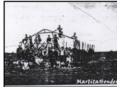
Ref.145; Foto de la construcción de la Iglesia Asamblea de Dios, datos y foto. Gentileza Héctor Miranda
