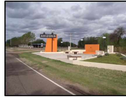
Ref. 559. Fuente: Acceso Oeste, foto propia
