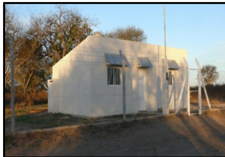
Ref. 511. Fuente: Esta edificación, que sería la operadora de la red cloacal, está construida en zona quintas, continuación de la calle 12 de Octubre.
