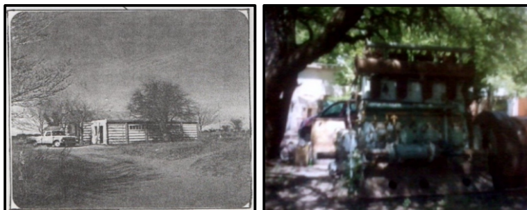
Ref. 376 a 379. Fuentes: Arr. izq.:Obreros construyendo el galpón para la Usina, gentileza de H. Miranda, además otras vistas de la usina y vehículos. En la actualidad está destruída. (2016) Ab. Izq.:Copia de recorte de diario, del Arch. Privado N° 12708, de E. Tello Cornejo, Año 1976. Inauguración alumbrado público a gas de mercurio. A la der. Foto propia de uno de los motores que supieron generar energía para el pueblo.
